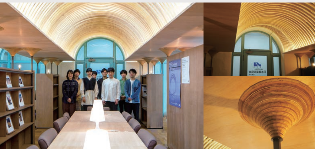
(写真:左)部屋の扉から奥へと続くアーチ。その下の本棚によって執務室、会議室、ライブラリーと部屋の機能を分けている。中央2人が伊賀さん、周戸さん。(右上)90本の部材からなるルーバーとしてアーチを構成。アーチ1本につき、ショップボットで切り出した4つのパーツをつなぎ合わせている。(右下)天板を支える円錐部材。ショップボットで切り出した13枚の円形を貼り重ねている。撮影・萬野光雄、周戸南々香
