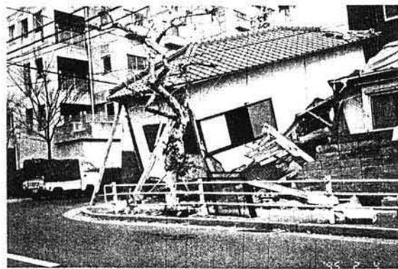
2Fは外観上変形しないまま大傾斜している家、自身も傾斜している家、歪んでいる家とあるが、2F自身の振動にたいする強度は比較的十分に見える。1Fの崩壊の仕方による2Fへの影響の方が大きく、それで変形したと思われるものが多い。
