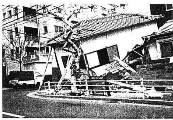
2Fは外観上変形しないまま大傾斜している家、自身も傾斜している家、歪んでいる家とあるが、2F自身の振動にたいする強度は比較的十分に見える。1Fの崩壊の仕方の差による2Fへの影響の方が大きく、それで変形したと思われるものが多い。
