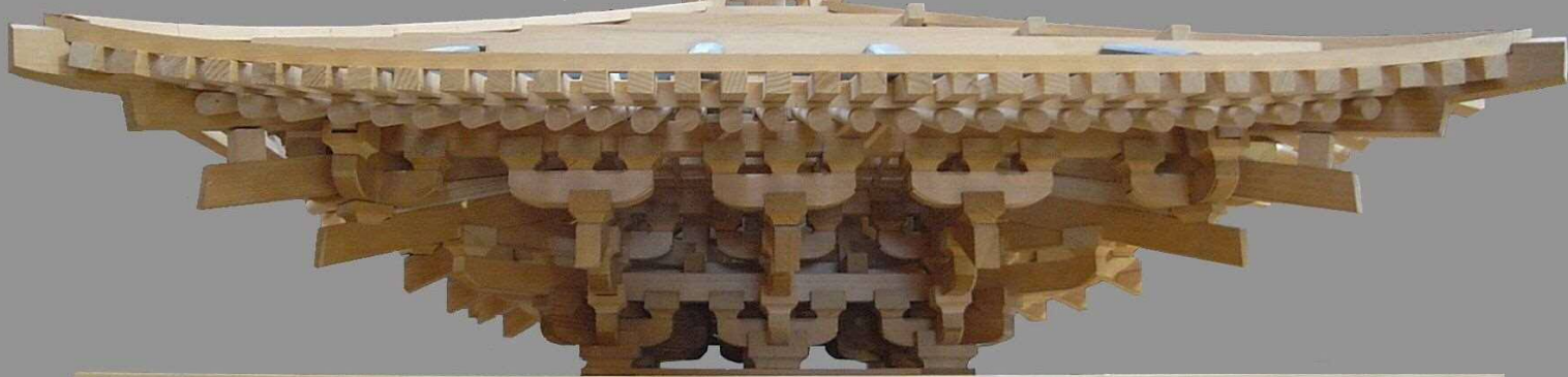
薬師寺東塔三層部構造検討模型
