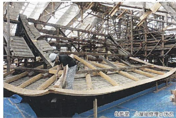
写真3：伽藍堂 小屋組修理の状況
