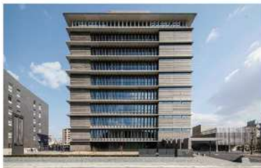
第3回きのくに特別賞・きのくに県民賞「和歌山地方合同庁舎」 設計：株式会社日建設計 設計部 施工：東急建設株式会社 大阪支店
