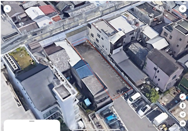
北西側上空よりの見下ろし
