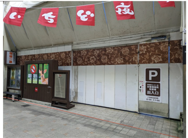
東側道路（アーケード）内、北東側から
