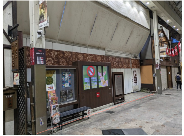
東側道路（アーケード）内、南東側から
